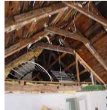
Beispiel: Zu sanierendes, teildämmtes Dach
